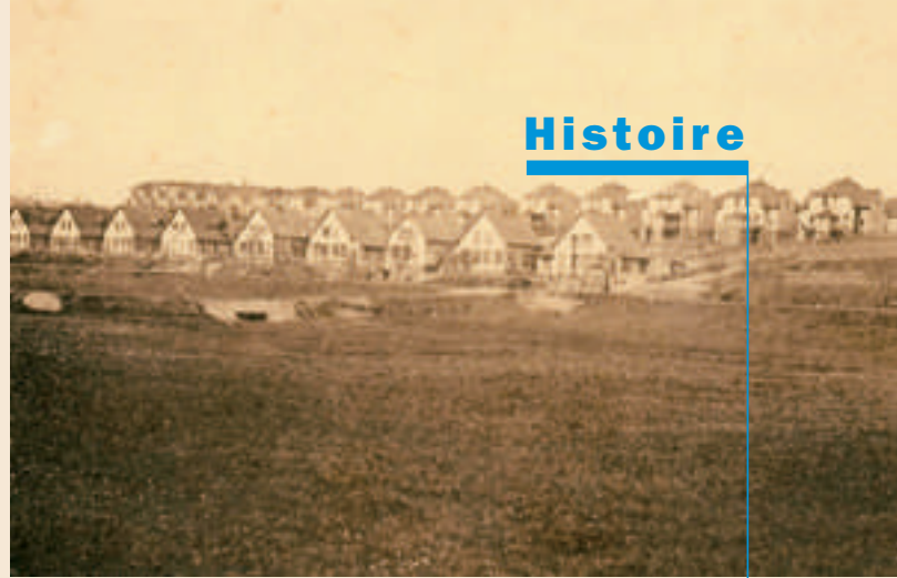
▲ Les premiers travaux de la cité Sainte-Barbe démarrèrent à partir de 1905. Elle fût reconstruite progressivement à partir de 1975.
