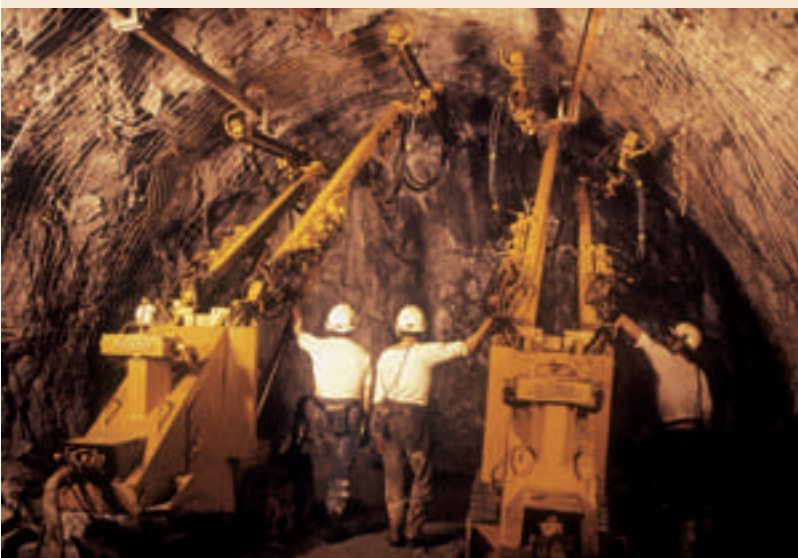
▲ Creusement dans le champ de Cocheren. Le JUMBO permet la mécanisation de la foration des trous de mine.
